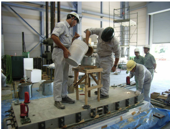
図-6 2層目グラウト材の充てん方法
