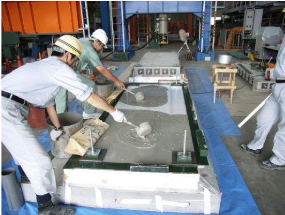
図-5 1層目グラウト材の充てん方法
