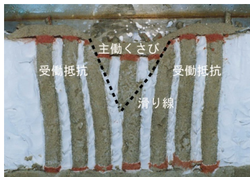
図-2.11 改良地盤の破壊状況 (寺師ら, 1990 に加筆修正)
