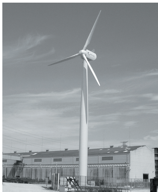
写真-2.1 実証試験の全景（駒井富津工場）
