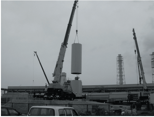
写真-2.5 タワー架設
