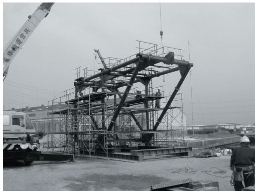
写真-2.7 回転装置地組み
