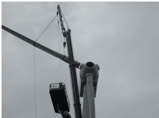
写真-2.11 ブレード架設
