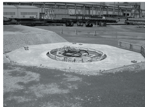
写真-2.4 基礎コンクリート施工
