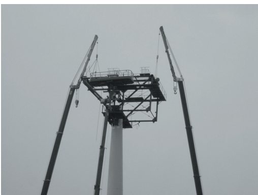
写真-2.8 回転装置の架設
