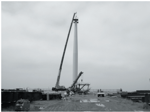
写真-2.6 タワー最終ブロック架設
