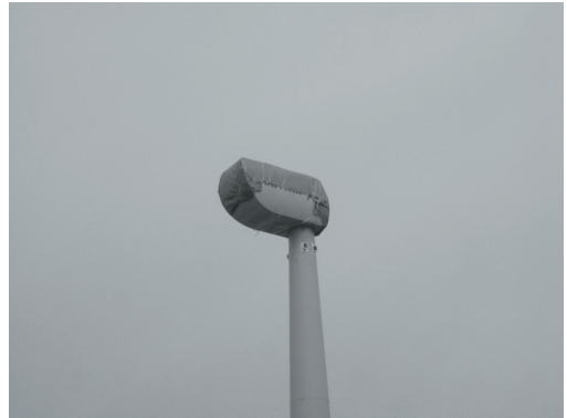
写真-2.10 ナセル架設完了
