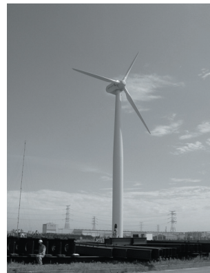
写真-2.12 架設完了
