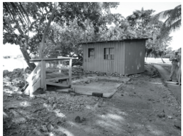
写真-29 図-37 の流された建物①
