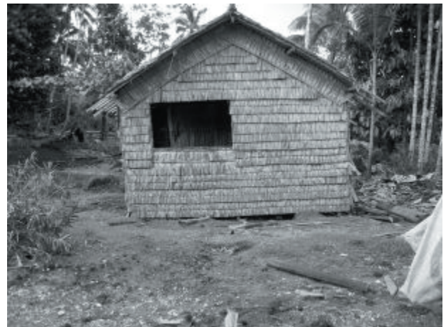
写真-32 流された建物①
