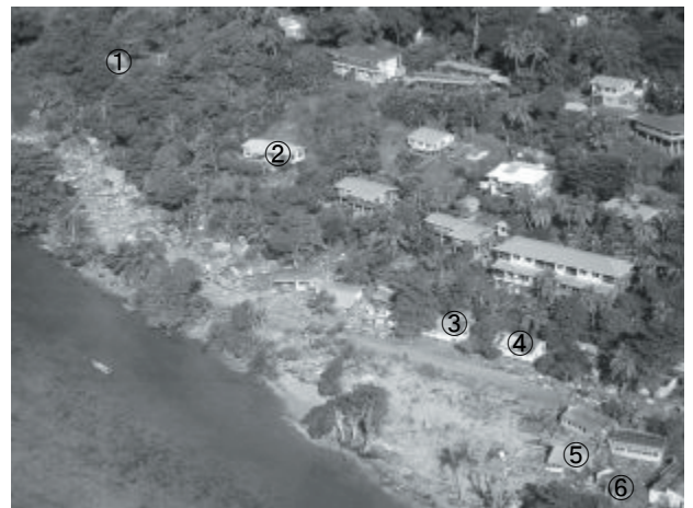
写真-21 マラケラバ 1 の被災状況 (1)
