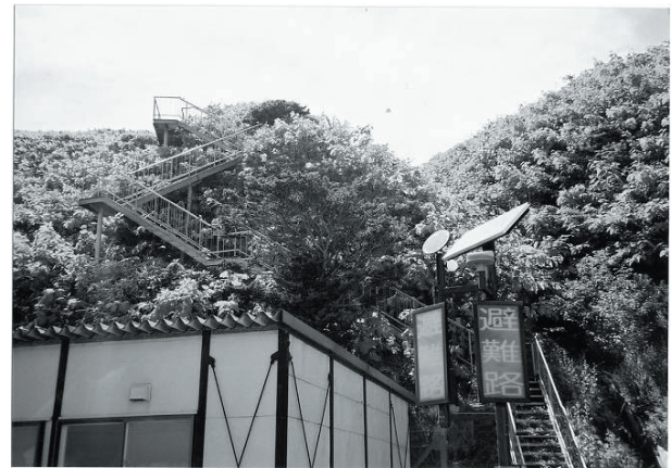
写真-40 避難階段（奥尻島の例）
