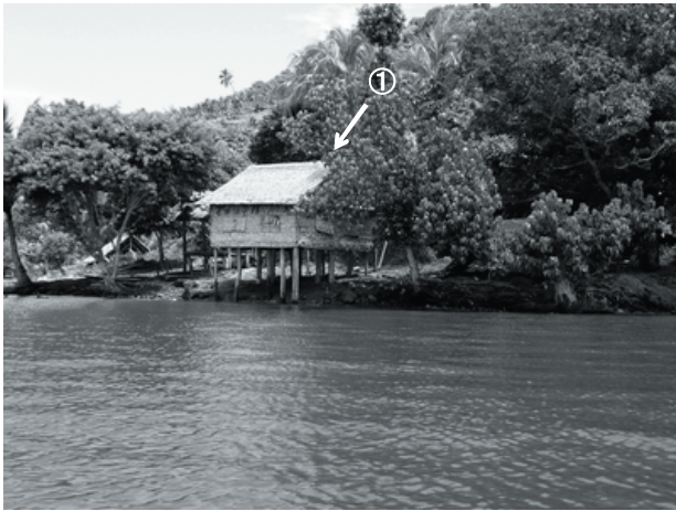
写真-10 大きな被害を受けていない高床式住居
