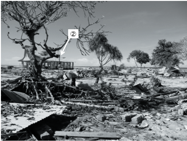
写真-12 ティティアナの被災状況
