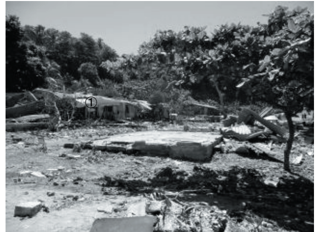
写真-19 マラケラバ3の被災状況(1)
