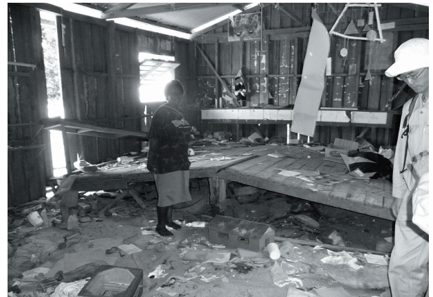
写真-30 痕跡14の建物の内部
