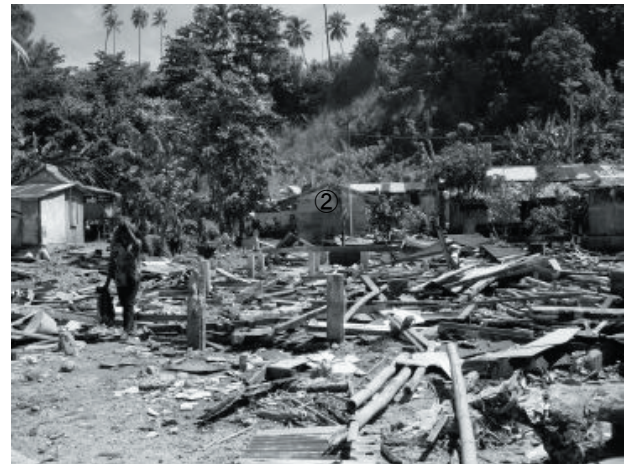
写真-20 マラケラバ3の被災状況(2)
