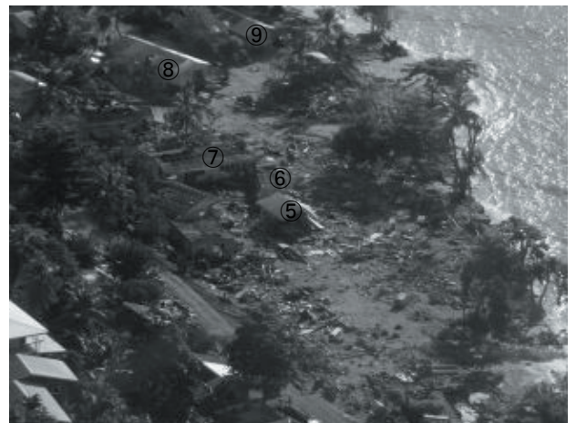
写真-22 マラケラバ 1 の被災状況 (2)
