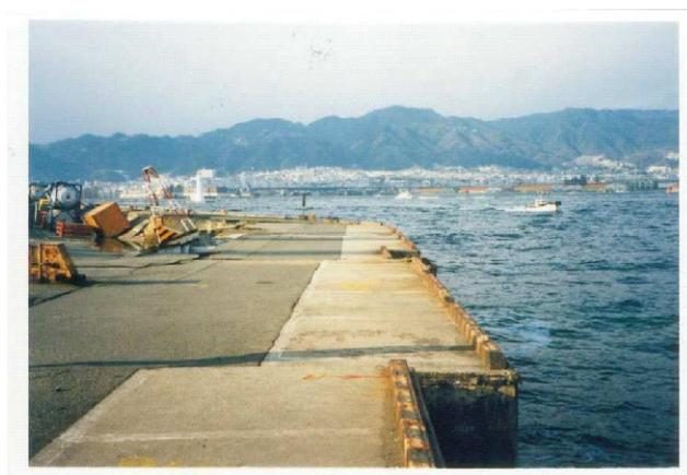
写真-2.2 重力式岸壁の被災事例
