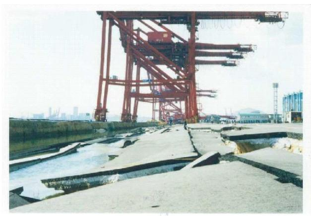
写真-2.1 重力式岸壁の被災事例
