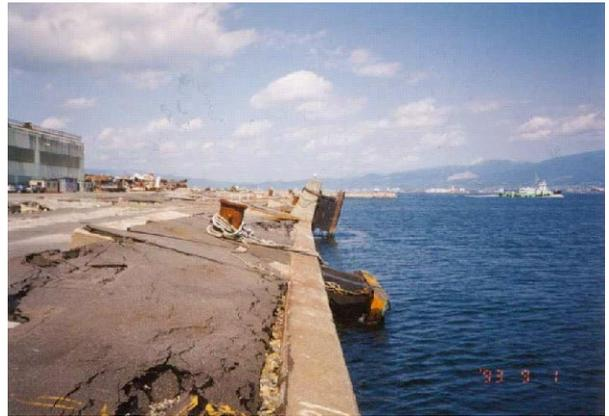
写真-2.4 函館港弁天地区の被害状況
