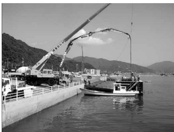
図2.3.18 土質系遮水材の打設状況
