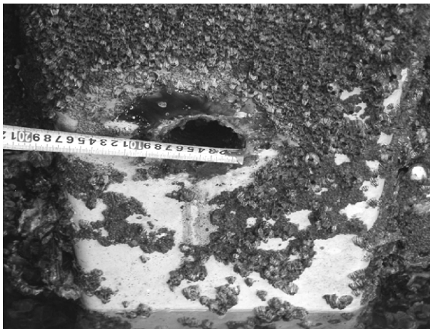
図3.4.12 U形鋼矢板に孔を開けた状況
