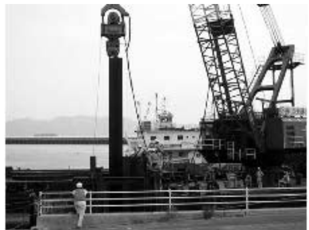
図2.3.17 箱形鋼矢板の打設状況
