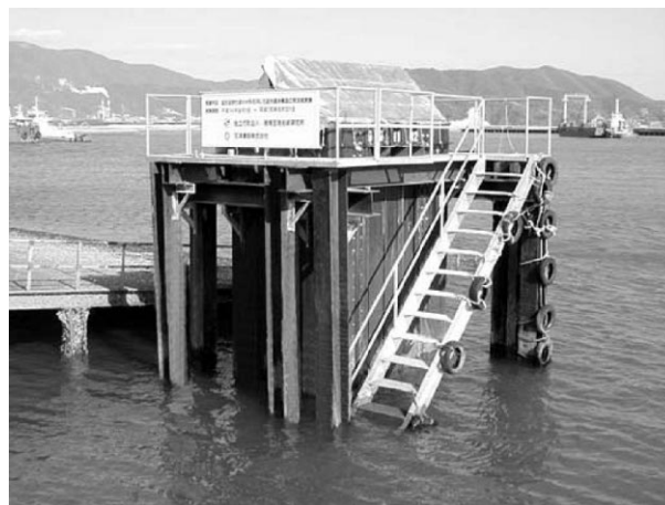
図2.3.20 実験構造物の全景
