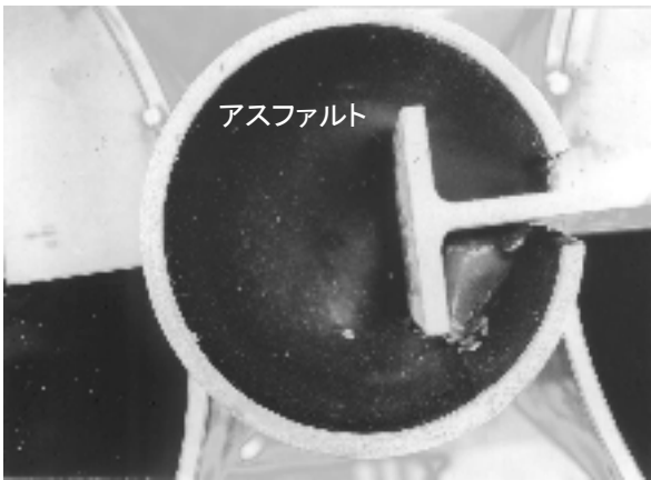
図 2.2.2 アスファルト充填継手
