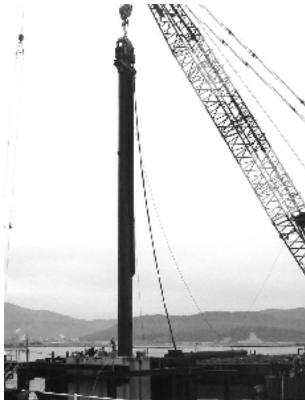
図2.3.4 鋼管矢板の打設状況
