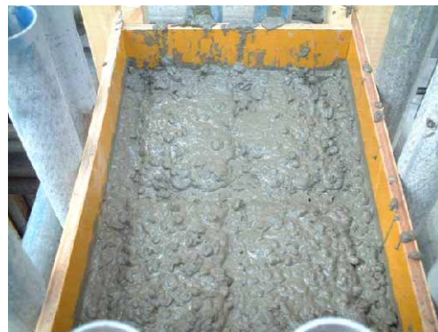
(b) 加振後におけるコンクリート表面の状況
