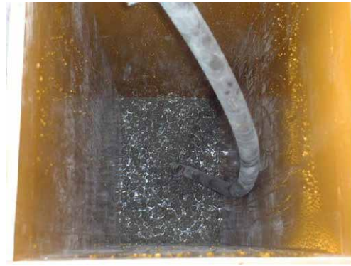
写真-13 内部振動機による締めめ状況
