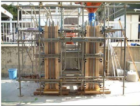
写真-12 供試体製作用型枠
