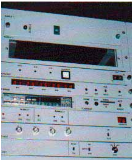
図-8 ERS-F 型強震計記録システムの外観
