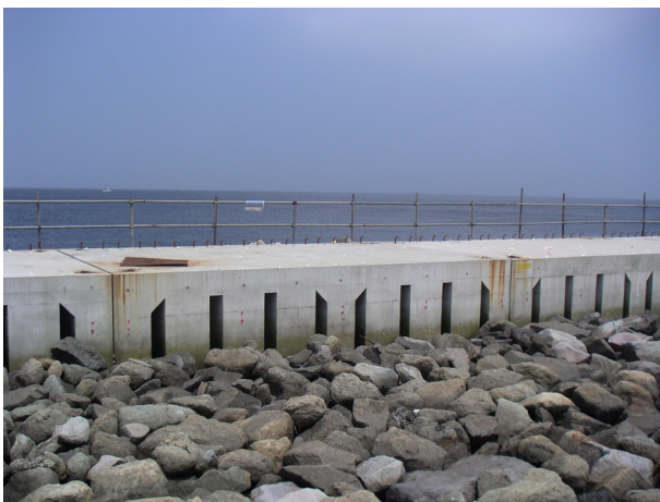
写真-1 馬堀海岸高潮護岸
