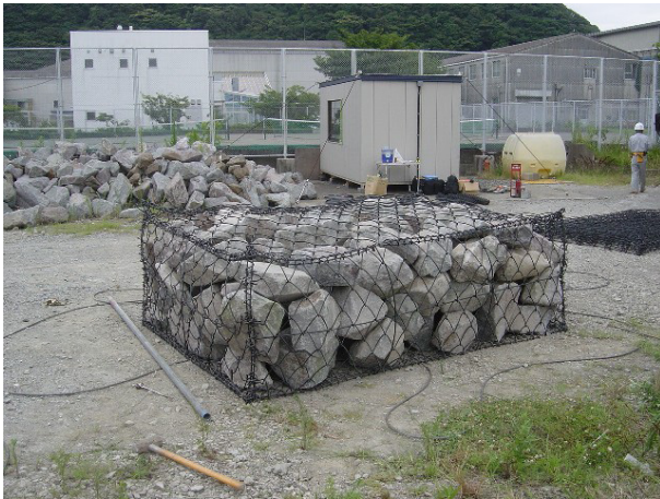
写真-2 フレキシブル仮設型枠を用いた石籠
