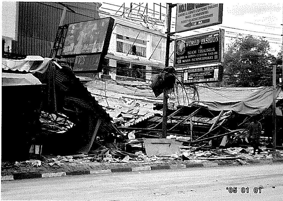
巻頭写真-3 タイ、プーケット島パトンビーチ (Patong Beach, Phuket Island) の市街地 (2005. 1. 1撮影) (海岸道路に面した木造の店舗は倒壊しているが、後方の鉄筋コンクリート製のビルは軽微な被害で残っている (痕跡高約6m))
