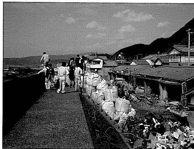
写真-2.5.1 護岸および背後地の被災状況
