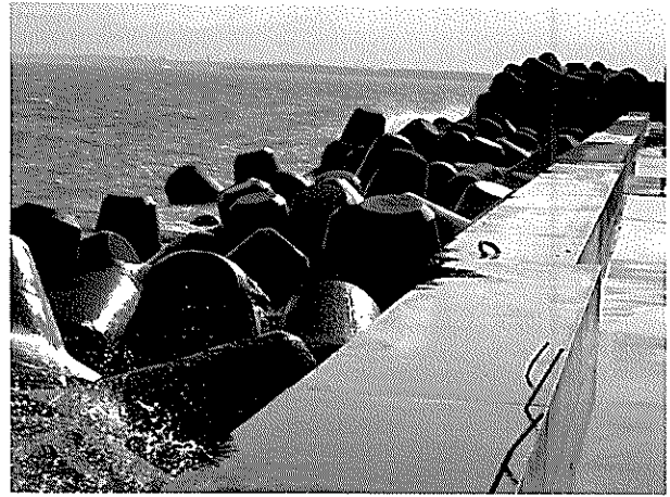
写真-4.2.1 消波ブロック被覆高 (宮崎港)
