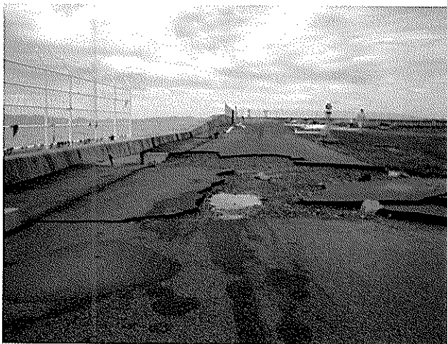
写真-2.4.4 B 護岸セキュリティフェンスおよび場周道路 破損 (平成16年8月31日撮影) (出典 関西国際空港株式会社)
