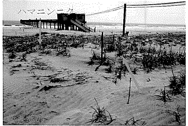
写真-24 対策後1年経過した後浜(2004年5月)
