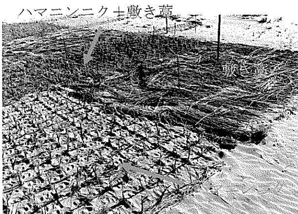
写真-23 追加対策工(2003年3月)
