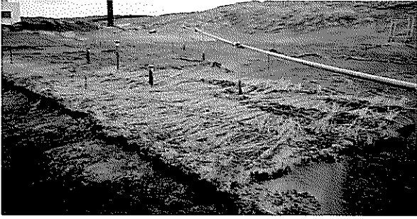
写真-21 敷き藁の設置
