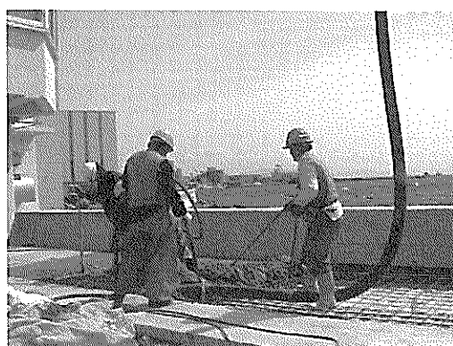
d) 打込み状況
