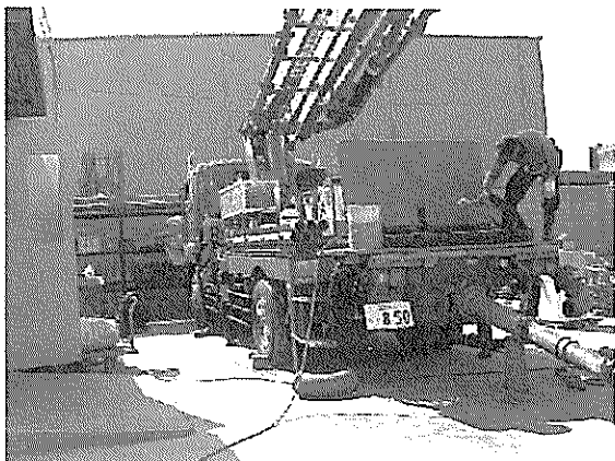
写真-3 ポンプ圧送実験に使用したポンプ車
