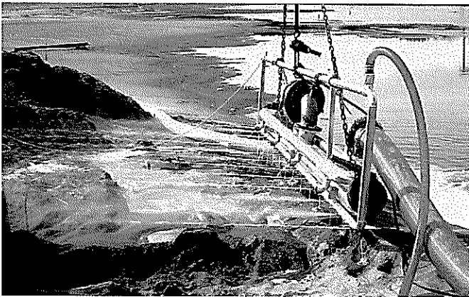
写真-12 水ジェット噴射状況
