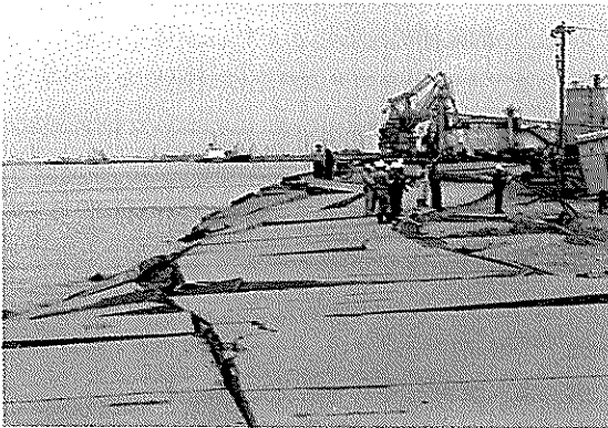
図-11 矢板式岸壁の被害 (秋田港下浜埠頭, 1983年日本海中部地震)
