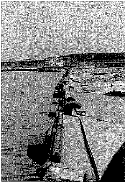
図-9 矢板式岸壁の被害 (秋田港大浜埠頭, 1983年日本海中部地震)
