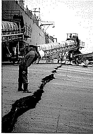
写真-3.1.2(a) 昭和南1号岸壁背後の亀裂
