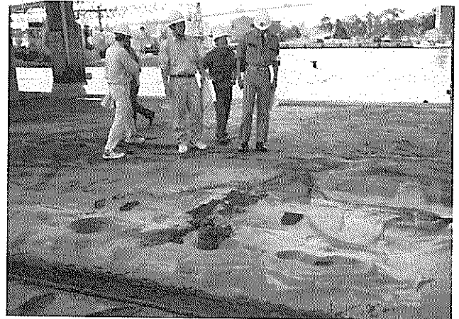
写真-3.2.2 液状化による被害状況
