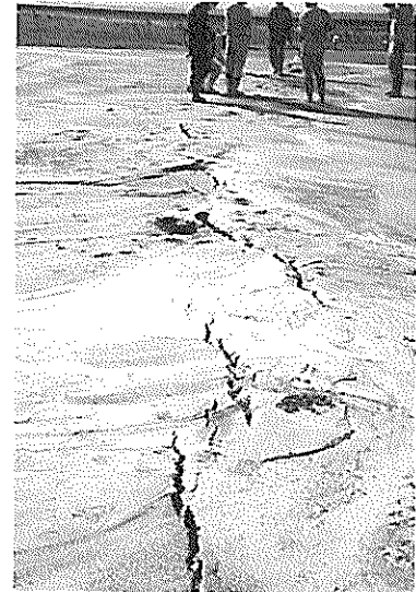
写真-3.6.4 滑走路過走帯部分の噴砂およびクラック (図-3.6.3④)
