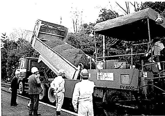
写真-3 アスファルトフィニッシャーでの敷きならし状況
