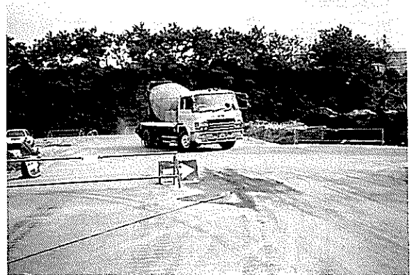
写真-9 交通開放直後の生コン車の走行状況
