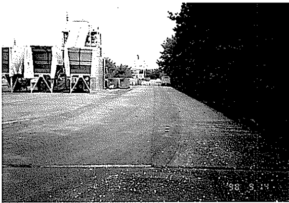
写真-7 走行試験終了後の路面状況
