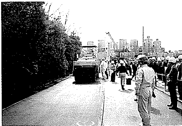
写真-4 振動タイヤローラでの転圧状況
