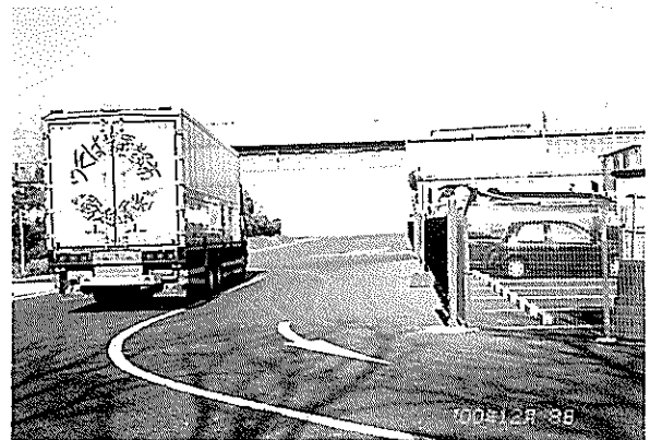
写真-12 供用 1.5 年経過後の路面状況
