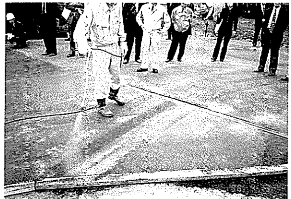
写真-5 塗布用ポリマーの散布状況
