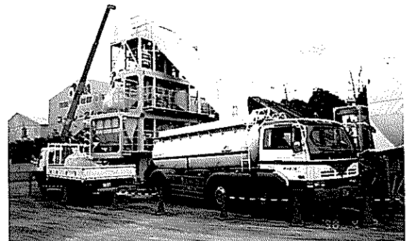
写真-2 常温複合混合物専用プラントでの製造状況
