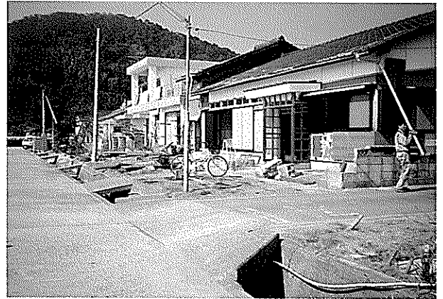
写真-1 小屋河内地区の住宅群の被害
