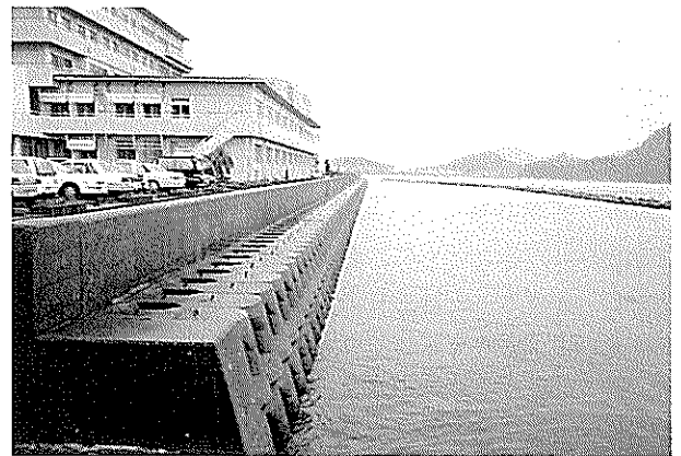
写真-2 上天草総合病院の外観
