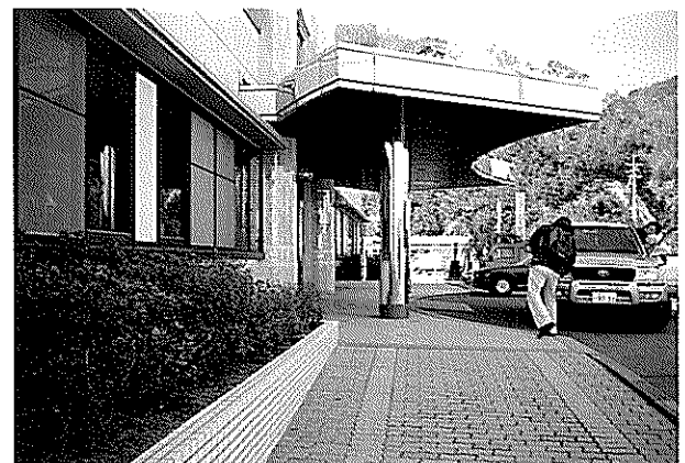
写真-3 総合病院入口の車止めの浸水跡調査
