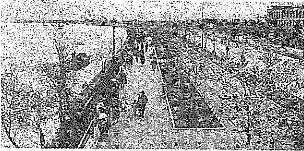
写真-3-16 旧隅田公園・左岸部
