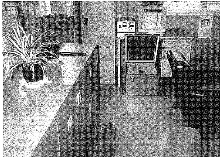
大分-G 観測小屋状況写真 Oita-G Photographs of accelerograph station
