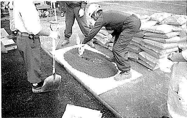
写真-2 樹脂系常温混合物の骨材・主剤と硬化剤
