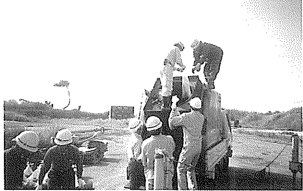
写真-4 粉末アスファルト加熱混合物の製造状況
