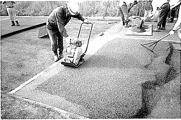
写真-7 振動タンパによる転圧
