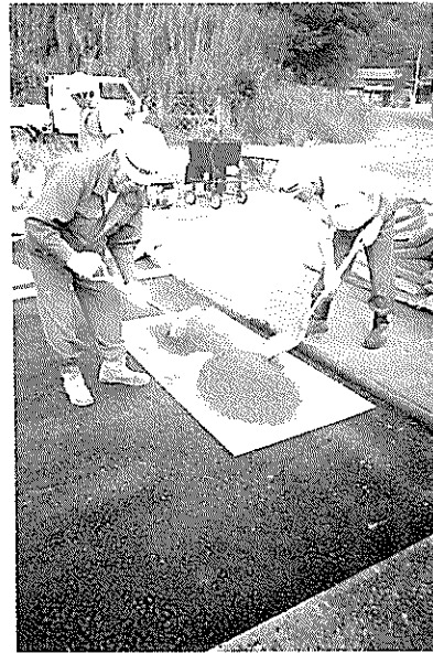
写真-5 樹脂系常温混合物の人力による製造状況
