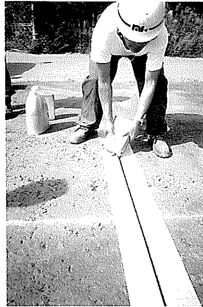
写真-10 ひび割れ注入作業の状況
