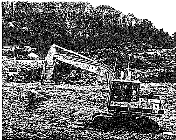
写真-3.3.4 無人機の実験概要図(大成建設)
