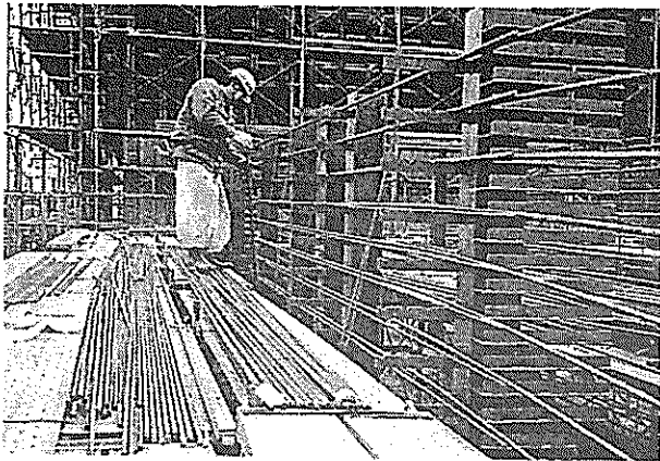
写真-5.4.1 ユニット製作状況
