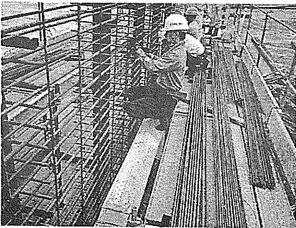
写真-5.4.6 ユニット製作状況
