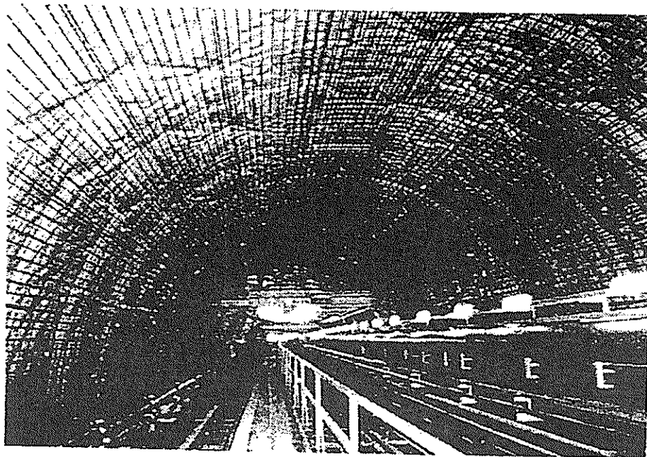
写真-3.1.1 (c) 上半鉄筋組立状況
