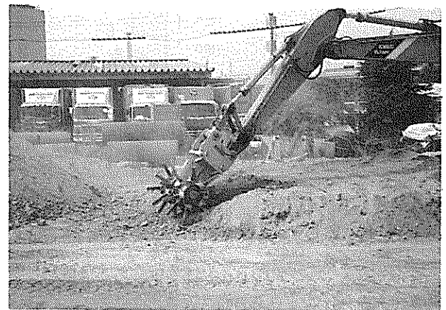
写真-1 固化材の混合状況
