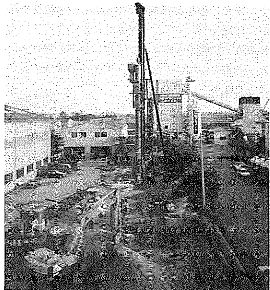
写真-2 打設機械と施工状況
