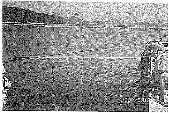
写真-3.2 ケーソン係留状況(港内側)
