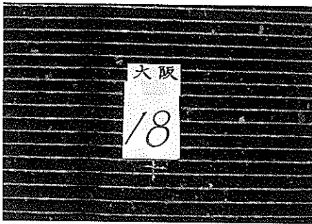
写真-1 ゴム付着のない舗装表面
