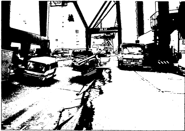
写真-24 ポートアイランドコンテナ埠頭12
