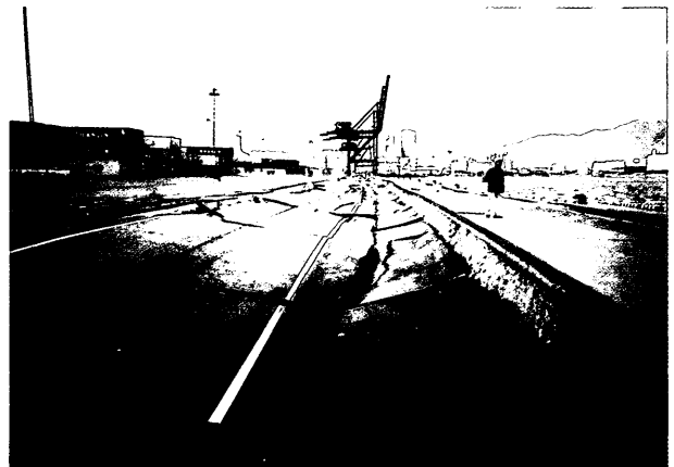
写真-17 六甲アイランド岸壁 (-12.0m)
