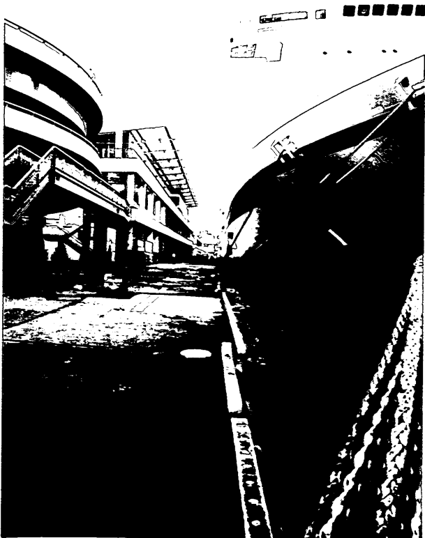
写真-8 新港第4突堤岸壁(-12.0m)
