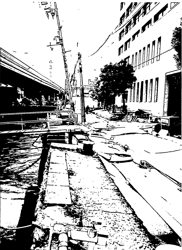
写真-3 京橋~メリケン間護岸
