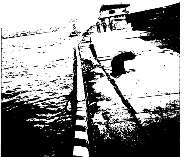
写真-6 新港第3突堤東
