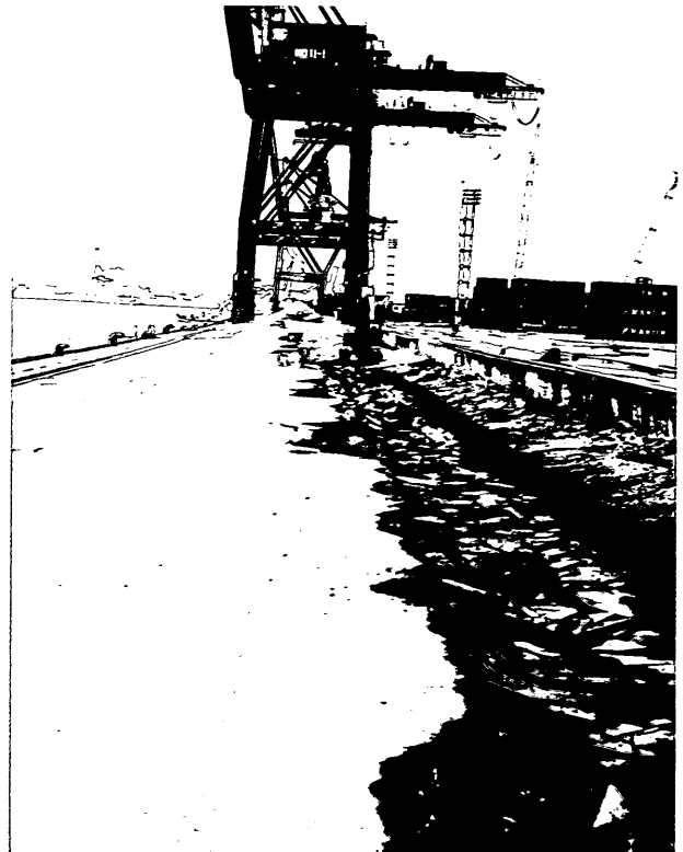
写真-23 ポートアイランドコンテナ埠頭11
