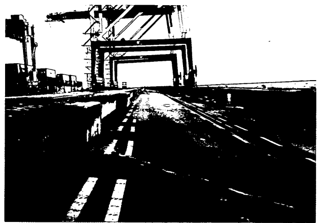
写真-22 ポートアイランドコンテナ埠頭5
