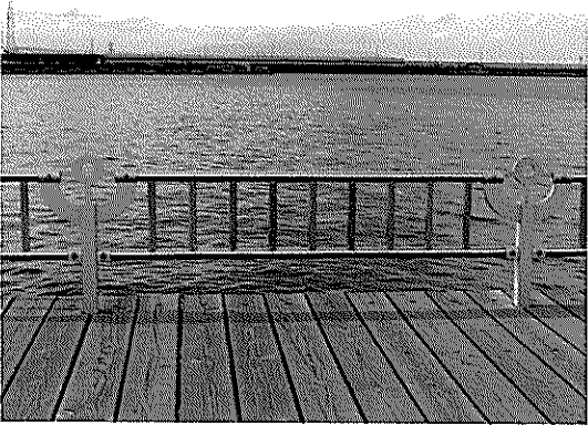
写真-3 転落防止柵・手摺（青森港）
