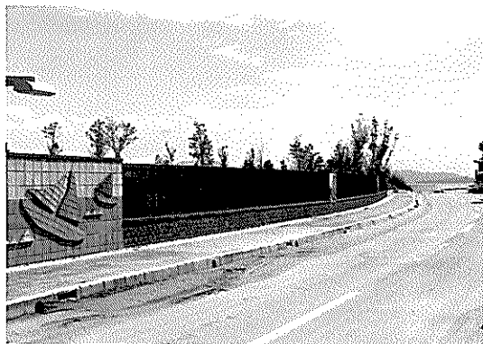
写真-9 侵入防止設備（柵式）（牛窓港）
