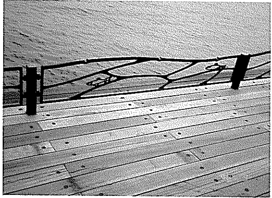
写真-2 転落防止柵・手摺（横須賀港）
