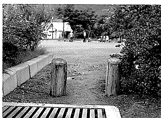
写真-12 侵入防止設備（車両用）（大船渡港）
