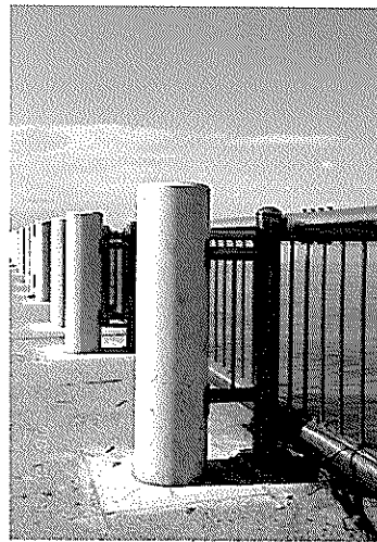
写真-4 転落防止柵・手摺（名古屋港）
