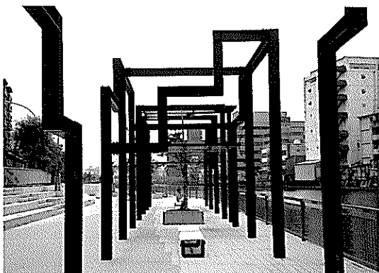
写真-29 休憩所（東京港）
