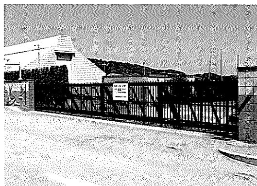
写真-10 侵入防止設備（門扉式）（牛窓港）
