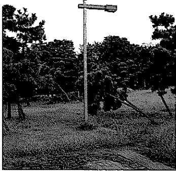
写真-13 照明設備（東京港）
