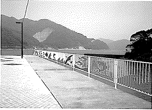
写真-1 転落防止柵・手摺（三木里港）
