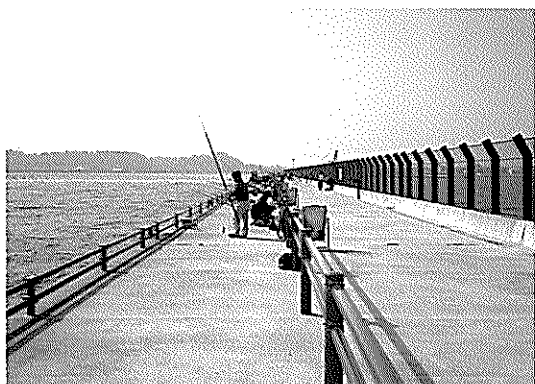
写真-7 転落防止柵・手摺（大洗港）
