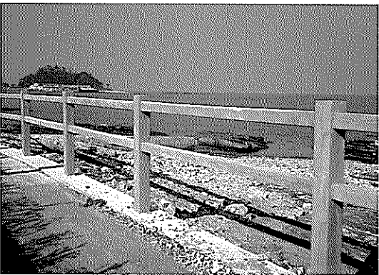
写真-5 転落防止柵・手摺（横須賀港）
