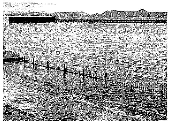
写真-6 転落防止柵・手摺（青森港）
