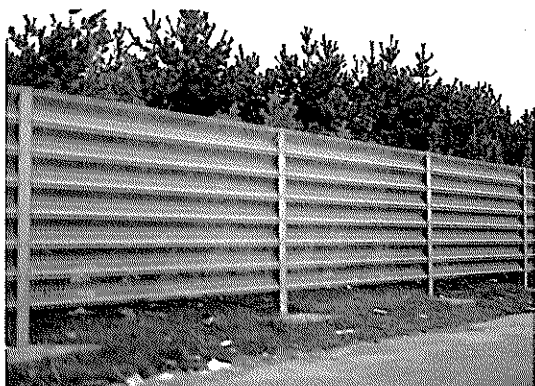
写真-27 波風防止設備（塩釜港）
