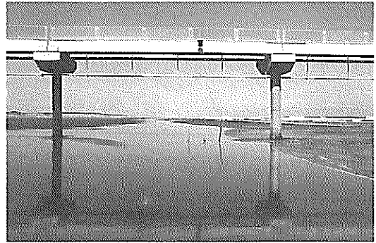
写真-6.2 波高計設置状況
