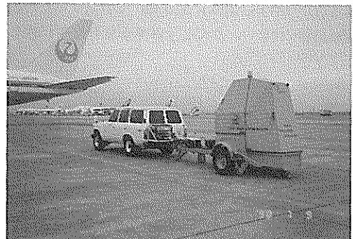
写真-2 20 tf FWD によるたわみ測定状況
