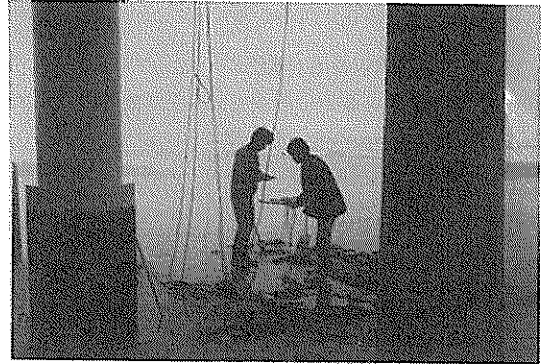
写真-4 波崎海岸波打際の送受波器埋設状況
