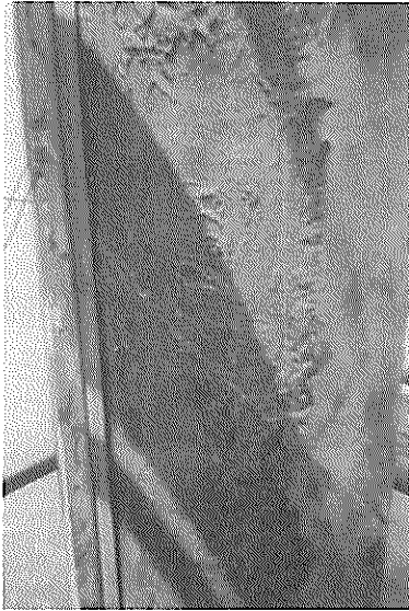
写真-23 ペトロタム防食工法の保護カバー 開放時の内部の状況
