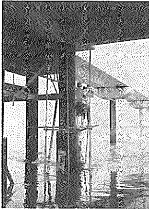
足場の設置作業
