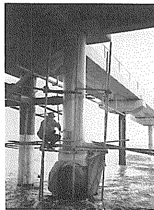
フッ素樹脂塗料の塗装
