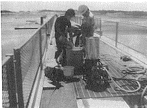
モルタルの混練り
