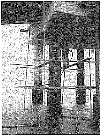
下地処理状況（2）
