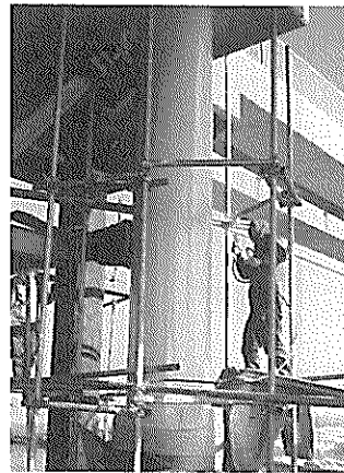
ガラス・フレック・ポリエステル樹脂塗料の塗装
