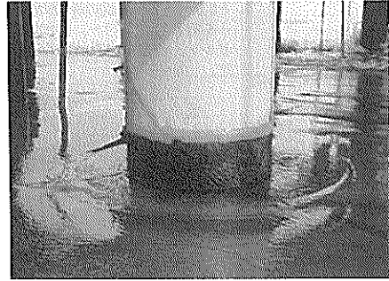
鋼管杭下部の被覆状況
