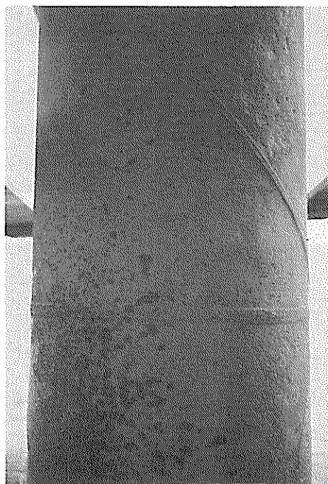
写真-17 鋼材表面の下地処理状況(2) サンド・ブラストによる。
