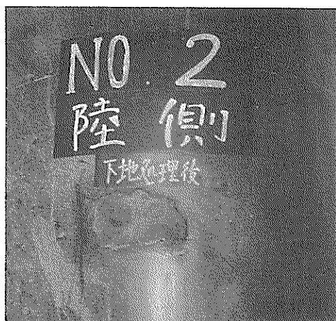
陸側，上部打傷，下地処理後の状況
