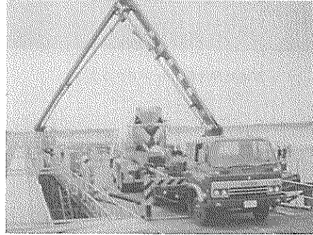
コンクリートの注入
