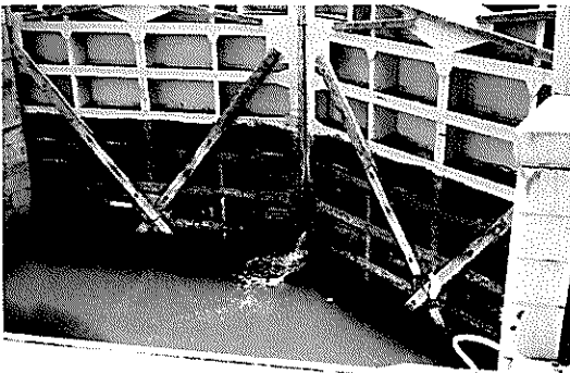
写真-1 閘門の老朽化状況（海上部）
