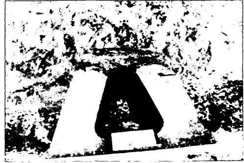
図-3.6(a) 防げん材の損傷状況
