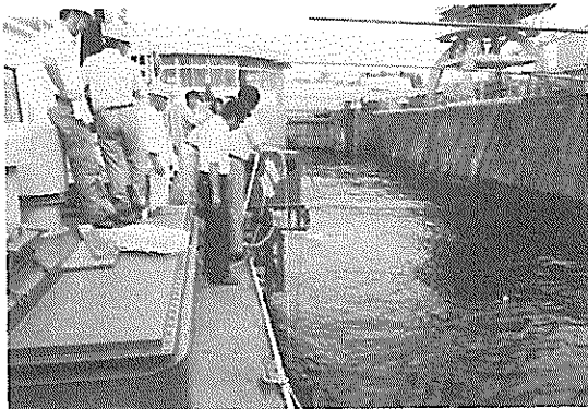
写真-2 クロスアレイ及び動揺補正装置取り付け
