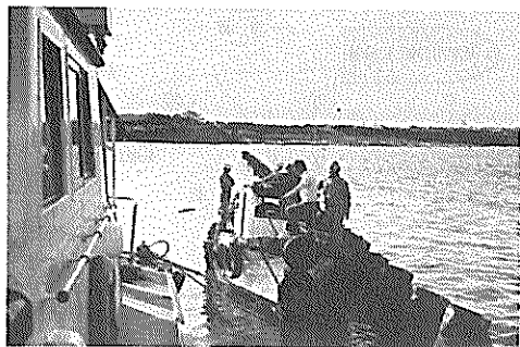
写真-3 ビックアップの設置作業
