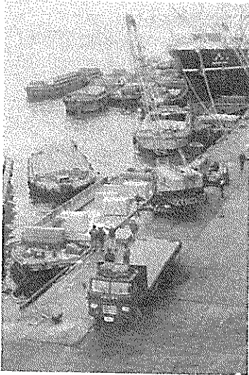
図5-4 トラッククレーンによる荷役(写真)
