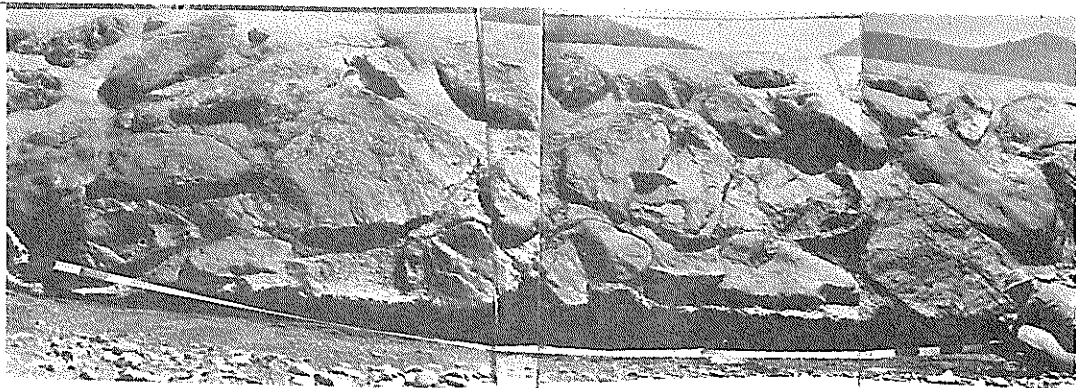
写真・附1-(3)-9 防砂突堤被災状況
