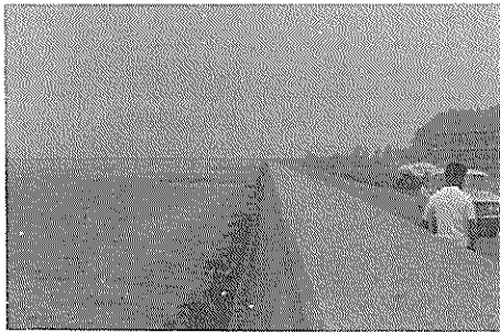
写真-6.29 波返し工と表のり工の状況
