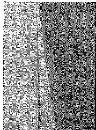
写真 - 5.36 背のりと天ば工の目地のひらき
