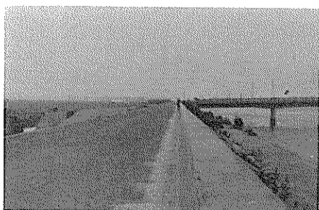
写真-6.17 波返し工法線の変形
