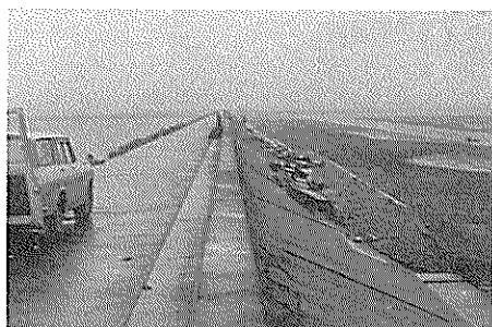
写真-6.38 表のりおよび波返し工
