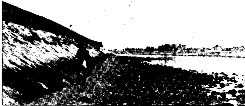
写真-23 宇治山田港神社地区護岸
