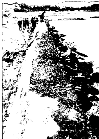
写真-19 滝港護岸
