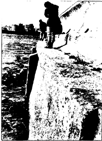
写真-21 津港江戸橋地区防波護岸
