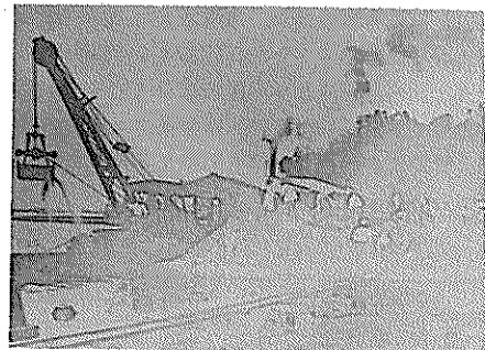
図2・6 プリストマン式浚渫機出雲号による埋立作業
