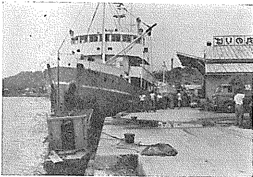
図 4-7 -3m岸壁より-4.5m岸壁を望む
