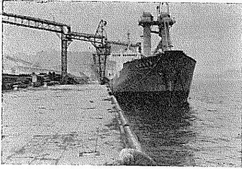
図 5-20 3岸中央付近のセメント積出設備
