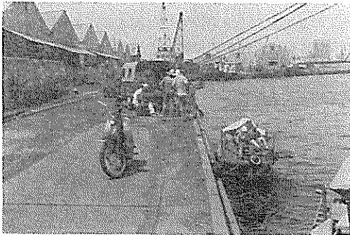
図 6.7 大阪港梅町西岸壁
