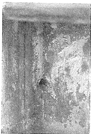
図 2-20 銃弾による穴 (H. W. L. 上)
