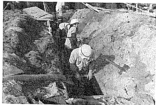
図 10.15 No.2 の掘出し
