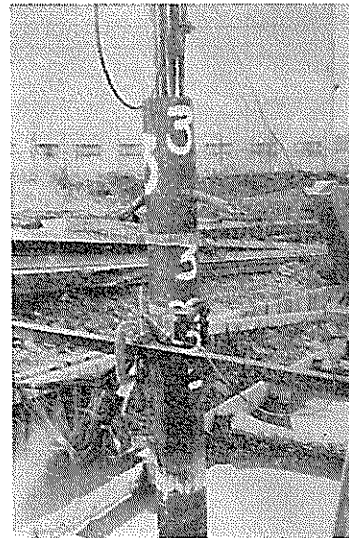
写真-6.1 Pile No. 3 引抜き試験
