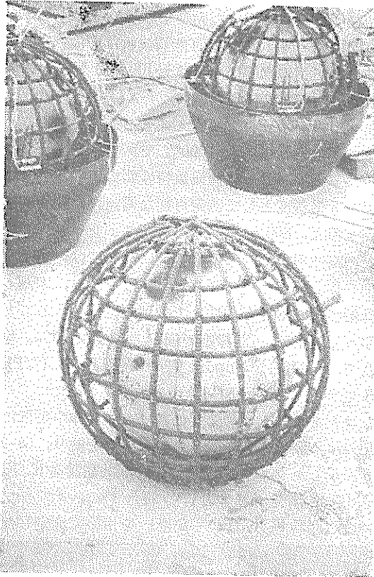
図-5 球形容器の配筋状況
