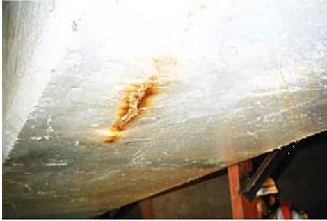
図-6 表面被覆適用後の再劣化事例
