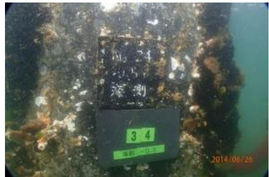
写真-5.3 水中部のポリエチレンシート溶着による試験補修部の写真 (杭 No.34)
