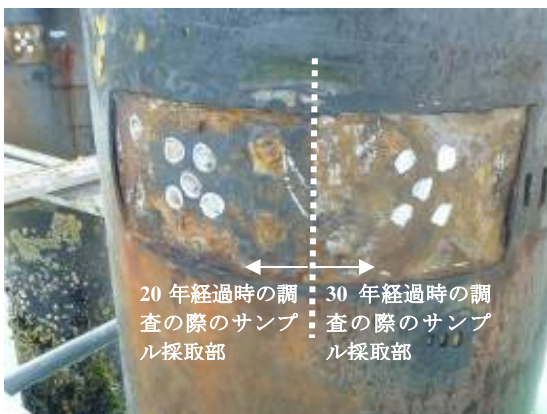
写真-5.6 鋼管杭の板厚測定部の外観（杭 No.33）
