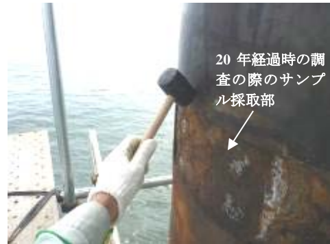
写真-5.8 打音検査状況
