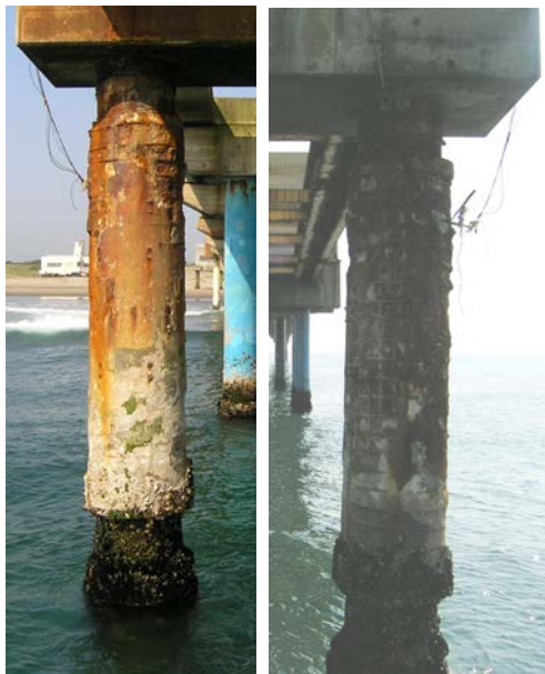
海側面 陸側面 写真-7.15 19年経過時の外観（2004年撮影）
