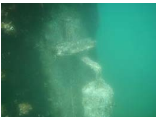
写真-8.2 磁石式流電陽極
