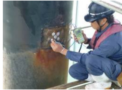
写真-5.7 鋼管杭の板厚測定状況（杭 No.33）
