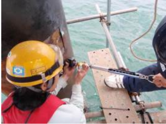
写真-5.4 ピール強度測定状況（バネ秤）
