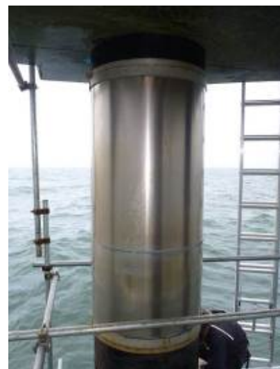
写真-5.17 No.33 杭のペトラタムテープ+チタンカバー工法による全周補修 (3年経過時)
