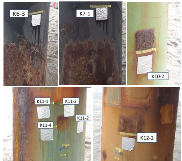
写真-3.4 錆発生の多い杭についての過去補修部、錆発生部近傍における計測部例
