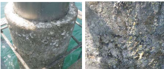
打継範囲 打継部の接写 写真-7.7 補修後19年経過時 (2015年撮影)
