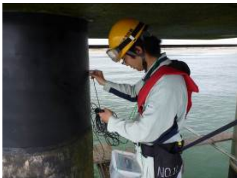
写真-4.7 膜厚測定状況
