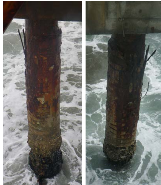
海側面 陸側面 写真-7.16 30年経過時の外観（2015年撮影）
