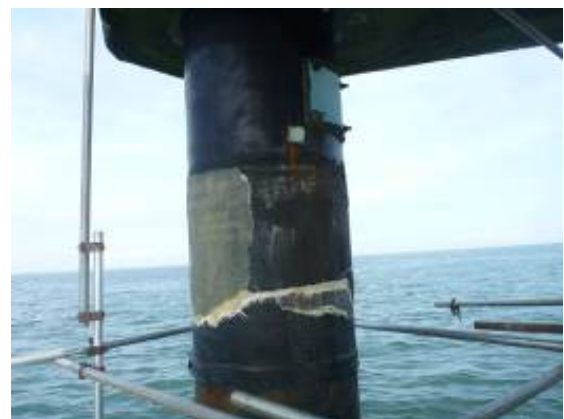
写真-5.16 No.35 杭の補修試験部 (27年経過時)
