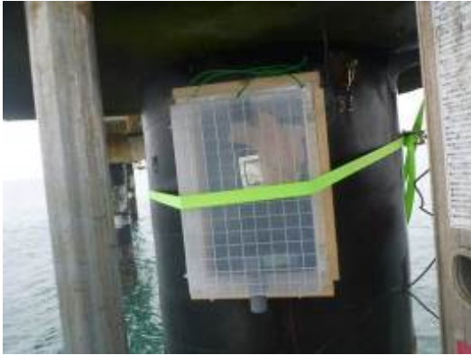
写真-4.1 絶縁抵抗測定状況
