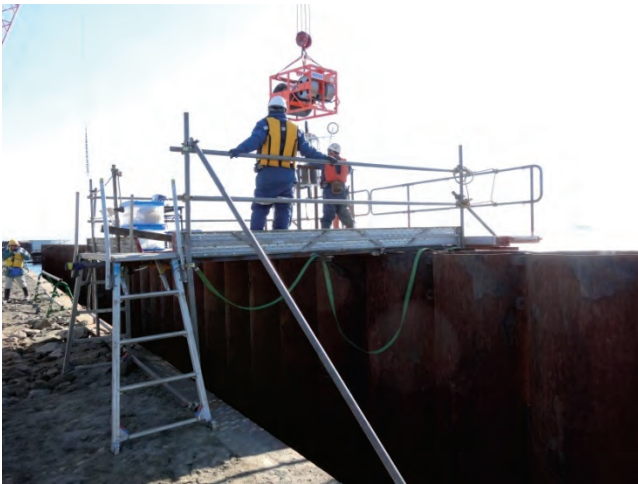
写真-4.1 計測用足場
