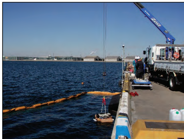
写真-3.4 ROVの海上への吊降ろし
