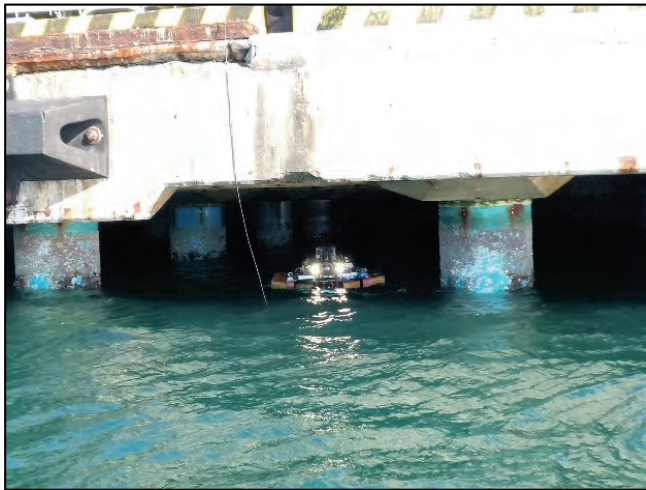
a) 栈橋外から撮影
