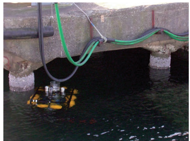
写真-1.2 ROVを用いた点検作業の試み
