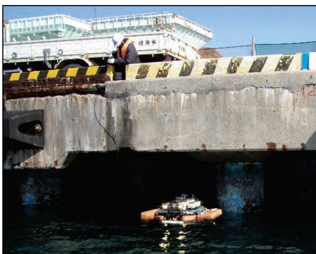
写真-3.5 ケーブル繰り出し状況
