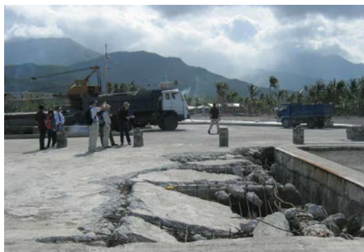
写真-5.37 建設資材を土運船に積み込むダンプ
