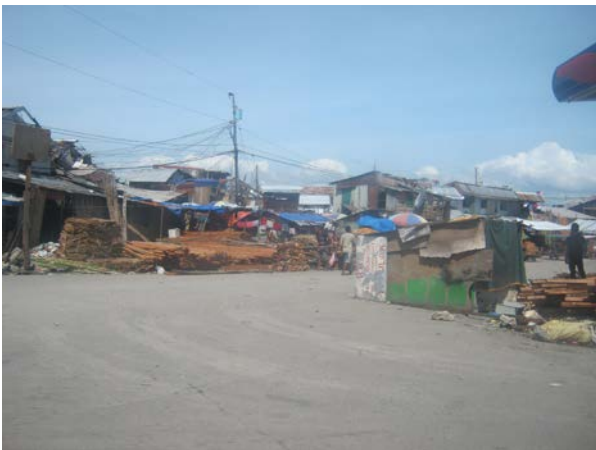
写真-5.27 背後の集落の被災（トタン造り） （タクロバン港）
