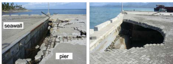
写真-4.13 リパタ港の栈橋および岸壁の破壊
