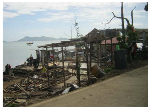
写真-5.5 周辺集落の被災状況（エスタンシア港）
