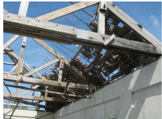
写真-5.32 旅客待合所の萱葺き屋根 (リパタ港)
