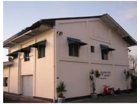
写真-5.6 港湾運営事務所 (ドマギット港)
