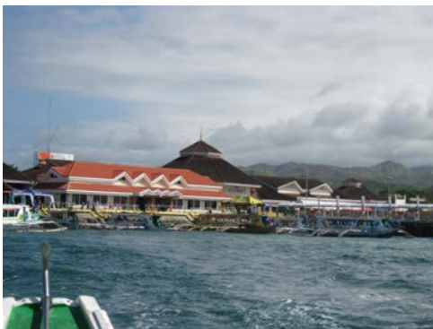
写真-5.13 旅客ターミナル兼港湾運営事務所遠景 （カティ克蘭港）
