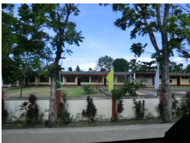
写真-4.18 学校の状況 (カティックラン港～リパタ港)
