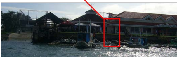
写真-4.11 カティ克蘭港の岸壁とターミナルビル
