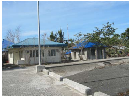
写真-5.18 港湾運営事務所（左側）と沿岸警備隊の詰所（右側）（リパタ港）
