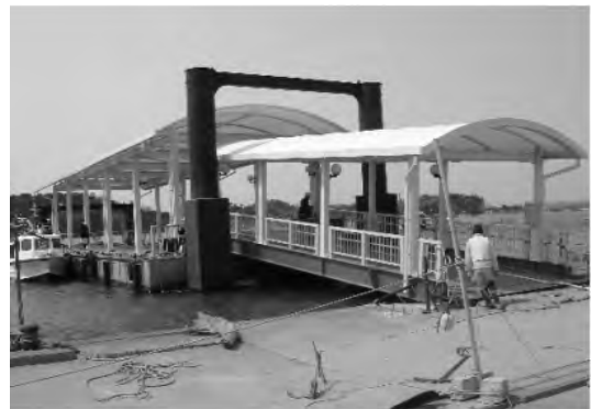
写真-1.4 ⑤寒風沢 (浮体・連絡橋・係留杭 全て流出)
