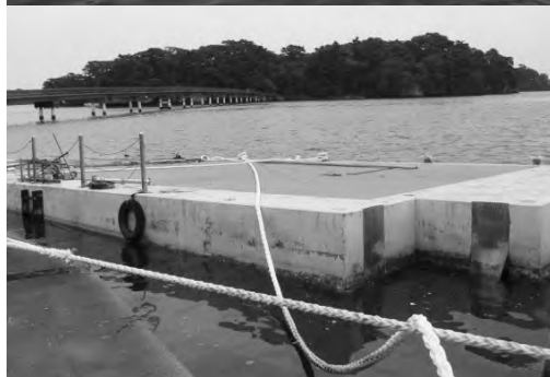
写真-1.8 ⑦松島 (B 杭係留) (浮体は流出, 連絡橋半水没, 係留杭のみ残存)
