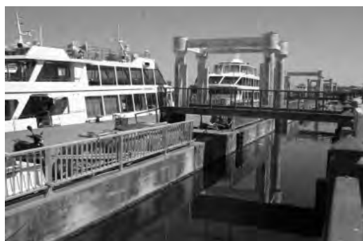
写真-1.8 ⑦松島 (B 杭係留) (浮体は流出, 連絡橋半水没, 係留杭のみ残存)
