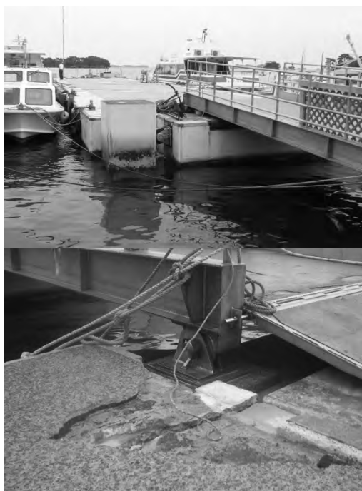
写真-1.7 ⑦松島 (A 杭係留) (浮体・連絡橋・係留杭 ほぼ無傷)
