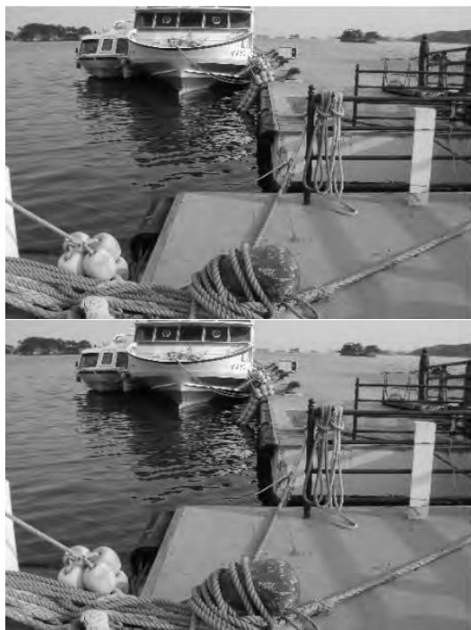
写真-1.6 ⑦松島 (チェーン係留) (浮体・連絡橋は軽微な損傷, 縦列に並んだ2基の浮体法線が左右にずれ)
