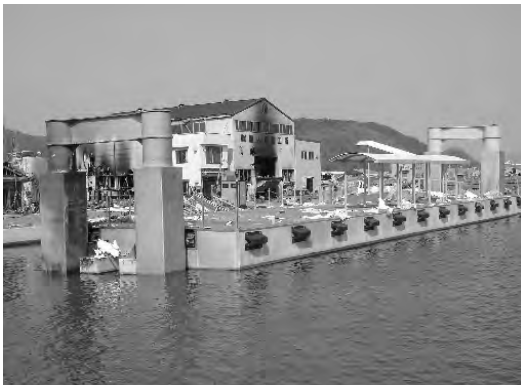
写真-1.2 ②浦の浜 (浮体・連絡橋は陸上に打ち揚げ，係留杭のみ残存)
