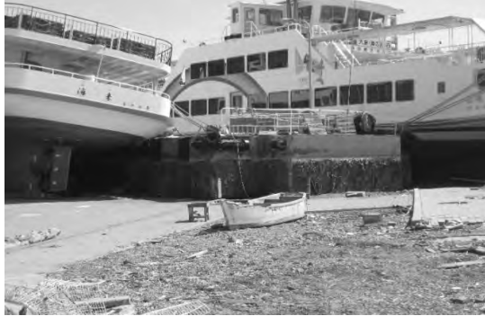
写真-1.2 ②浦の浜 (浮体・連絡橋は陸上に打ち揚げ，係留杭のみ残存)
