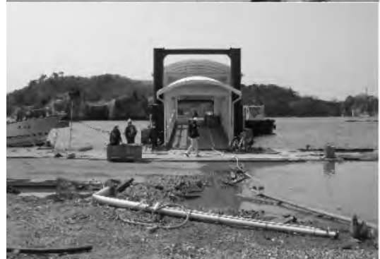
写真-1.5 ⑥野野島 (浮体・連絡橋・係留杭 軽微な損傷)
