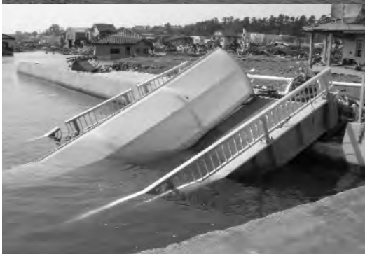
写真-1.3 ④石巻 (浮体・係留杭は軽微な損傷，連絡橋は半水没)
