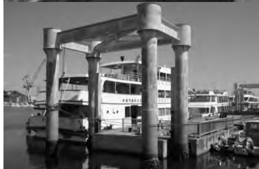
写真-1.9 ⑧塩釜 (浮体・連絡橋・係留杭 ほぼ無傷)
